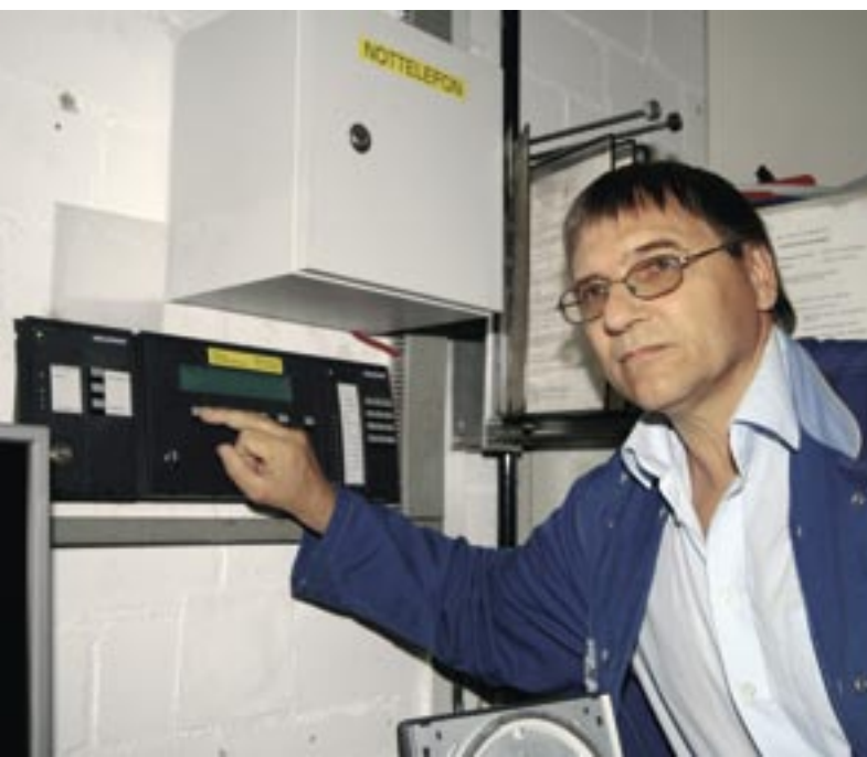
Jürgen Kahler ist als Meister der Elektrowerkstatt bei der INEOS Films GmbH unter anderem für die Brandschutztechnik zuständig.
