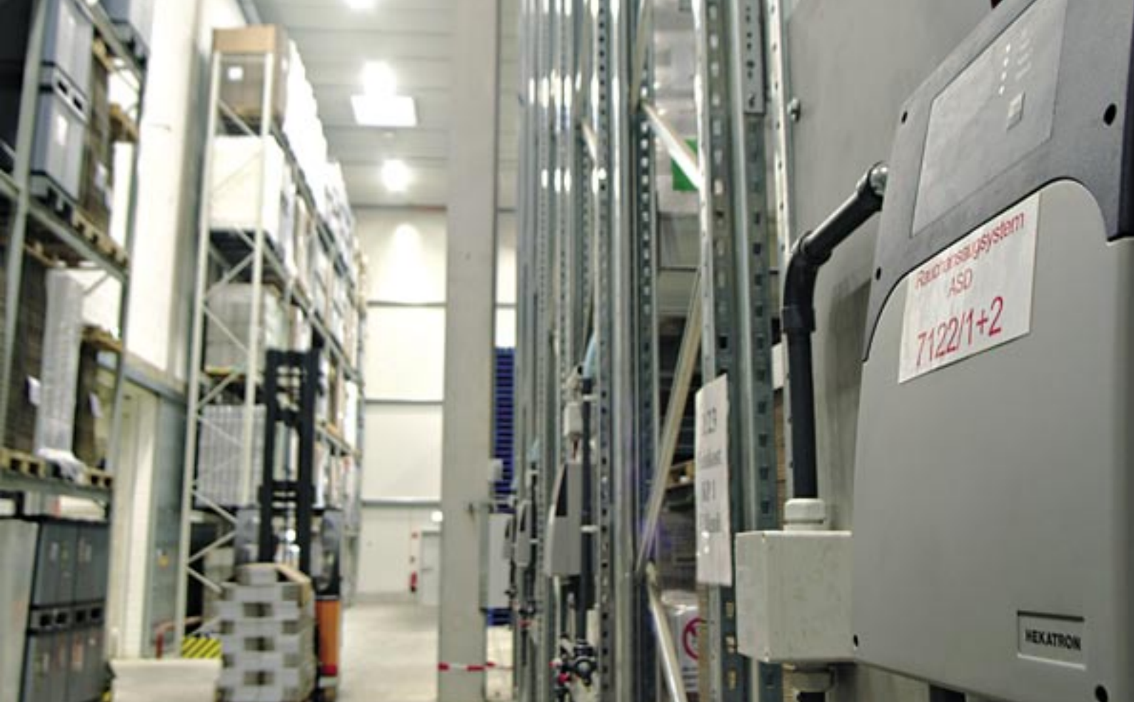
Das Hochregallager schützen ASD-Rauchansaugsysteme, die kleinste im Lager auftretende Rauchmengen detektieren.
