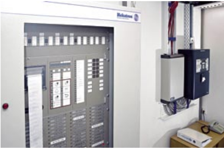
Alt und neu direkt nebeneinander: die alte HX-Zentrale (links) und eine der drei neuen Integral-Zentralen.
