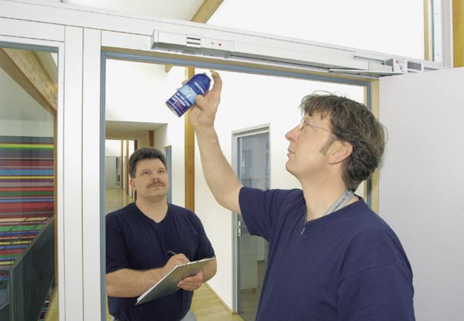
Andreas Frömert und Dieter König von Brantec (oben, von links) testen die Sturzmelder sowie den Funkrauchmelder (unten) mit Prüfgas. Auch der Treppenaufgang wirkt offen und freundlich (rechts).
