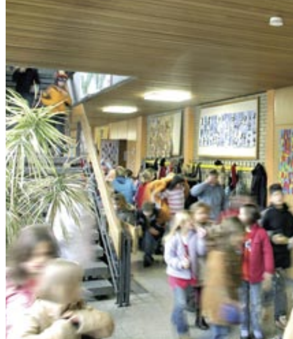
Oberhalb der blauen Druckknopffeuermelder befindet sich jeweils ein Funk-Interface Duo-Line als Schnittstelle zu den an der Decke angebrachten Rauchwarnmeldern.
