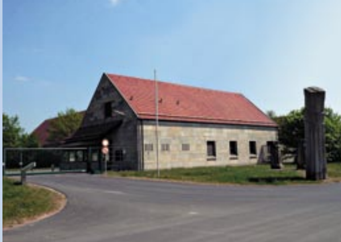
Vom Betriebsgebäude (links) aus werden alle Funktionen der vier Antennenfelder (unten und ganz links) umfassenden Erdfunkstelle überwacht.
