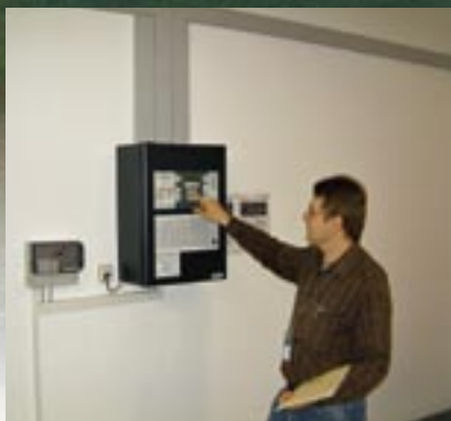
Lüftungskanalmelder (ganz links) überwachen die Abluft der Löschbereiche. Die Löschmittelbehälter (Mitte) enthalten Novec 1230. GTE-Servicespezialist Florian Reich überprüft die Integral Löschzentrale.
