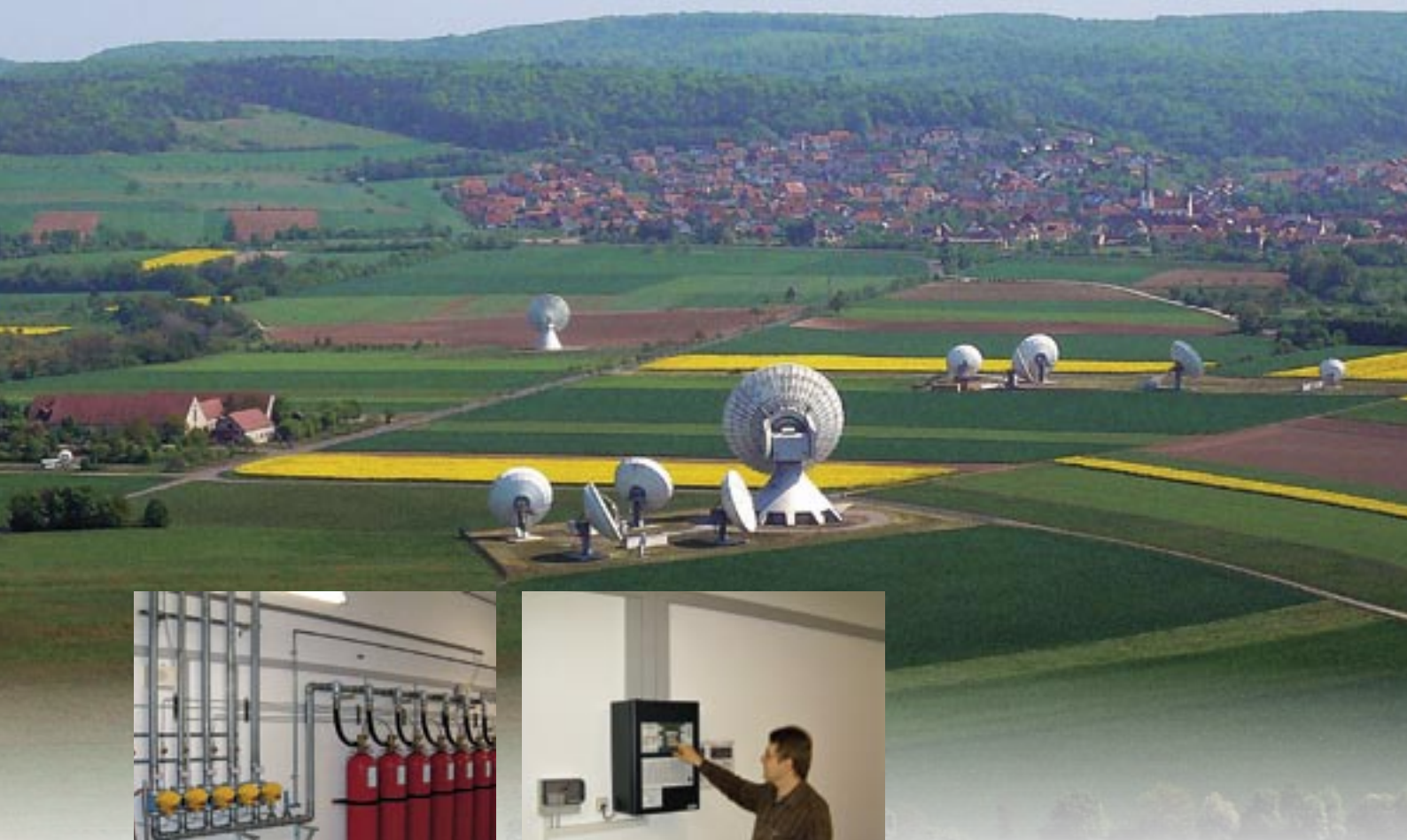
Lüftungskanalmelder (ganz links) überwachen die Abluft der Löschbereiche. Die Löschmittelbehälter (Mitte) enthalten Novec 1230. GTE-Servicespezialist Florian Reich überprüft die Integral Löschzentrale.
