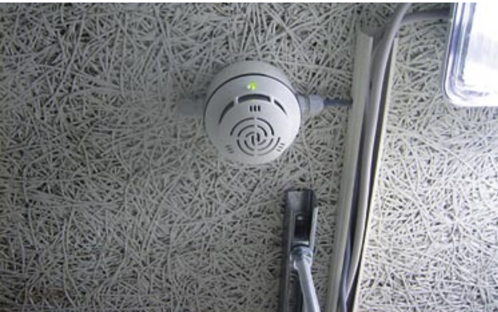
Kompakt präsentieren sich die mit Schnell Zündstrahlaggregaten arbeitenden Blockheizkraftwerke (ganz oben). Der in den Blockheizkraftwerken installierte ORS 142 (links) ist sicherheitstechnisch mit dem BHKW-Schaltschrank verknüpft.
