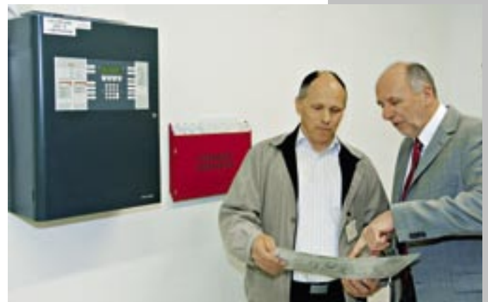
An die eindrucksvoll dimensionierte Zentralwarte sind sowohl die gesamte Löschtechnik (rechts) als auch die einzelnen Zentralen (unten rechts) angebunden.
