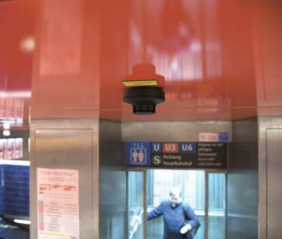
Einer der Steuermelder ist in Mattschwarz gehalten (oben). Leuchten signalisieren der Feuerwehr, welcher Ansaugrauchmelder ausgelöst hat (rechts oben).
