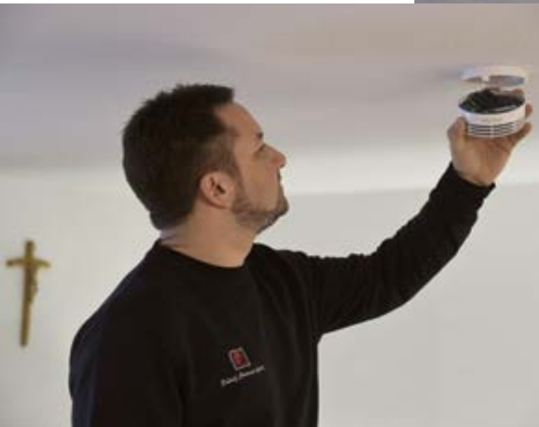
Christian Kneissl, Servicetechniker der Rudolf Strasser GmbH, installiert die Rauchwarnmelder (oben). Ihre Aufschaltung auf die BMA erfolgt über ein Funkinterface Genius (rechts). Im Untergeschoss wurden Mehrfachsensormelder montiert.
