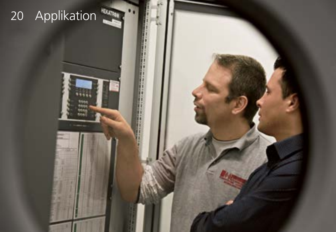
Rudolf Pietsch, Servicetechniker und Bauleiter bei der Kapfelsperger GmbH, und André da Silva (von links) an der Brandmelderzentrale (oben) sowie im Raum mit den Ansaugrauchmeldern.
