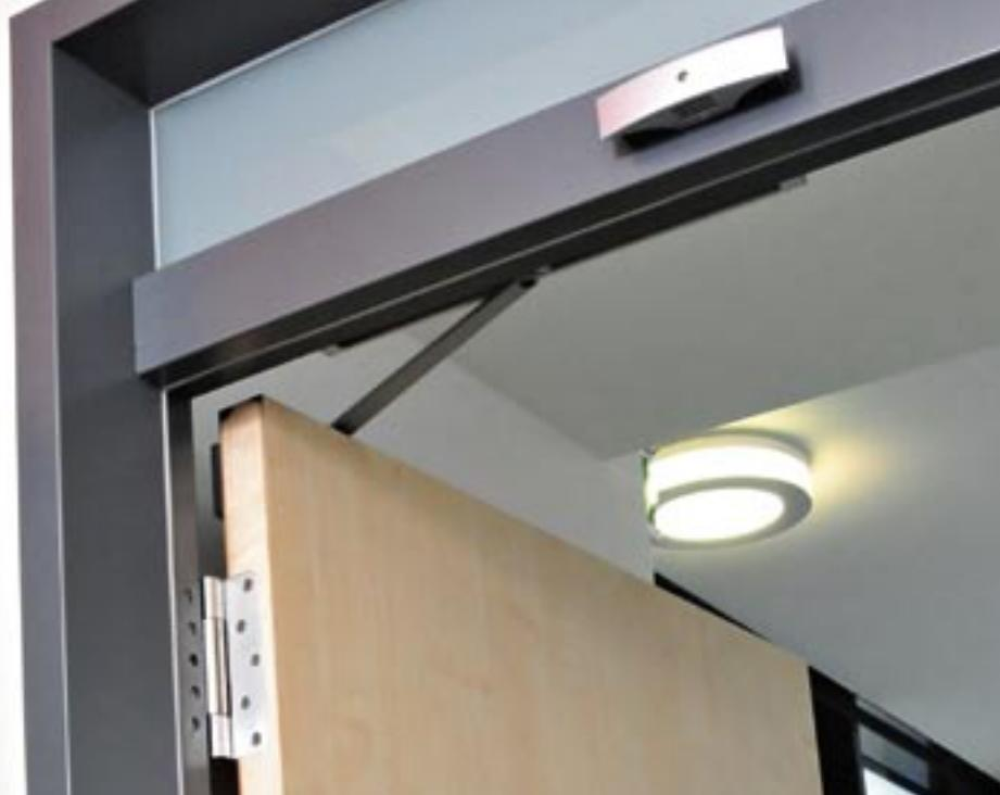
**Der Rauchschalter ORS 142 W mit Designabdeckung (oben) wird über der Türöffnung angebracht. Detektiert er einen Brand, löst der Freilaufürtürschließer (rechts) die Feststellvorrichtung aus. Das Netz- und Steuergerät SVG 522 (rechts unten) sorgt für eine unterbrechungsfreie Spannungsversorgung.**
